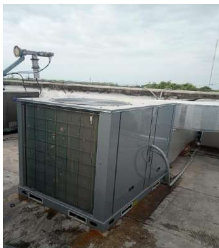
Instalación del aire acondicionado laboratorio e imágenes diagnosticas.
