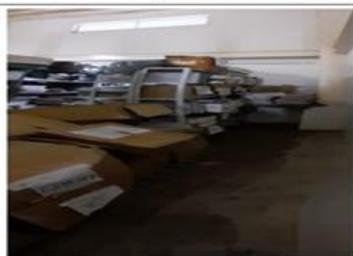
cuando llueve se presentan inundaciones debido a filtración del piso, mal estado de la canal y rejilla de ventilación
